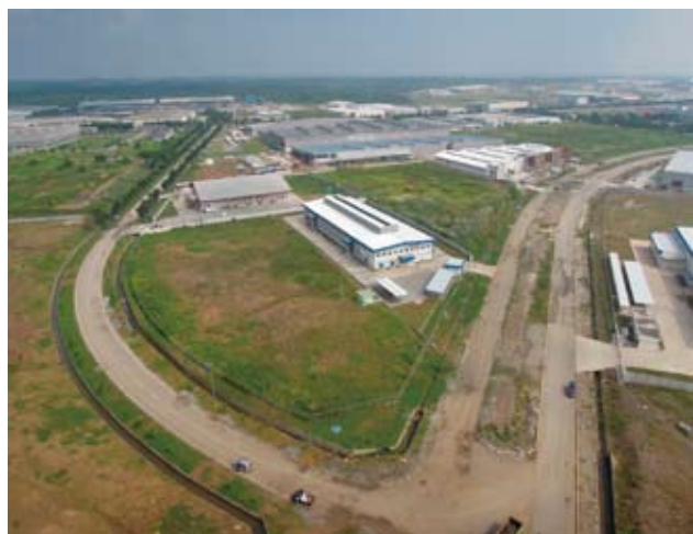
工場全景写真です。
