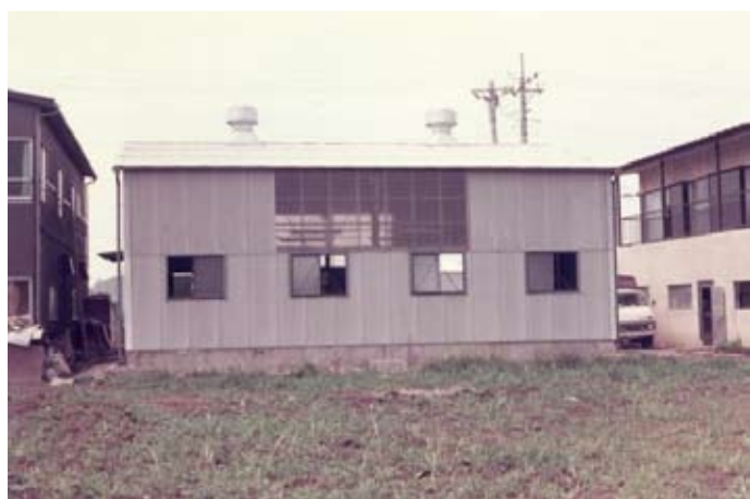
吉岡工場 外観
